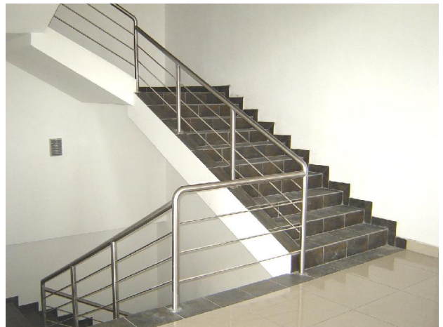
EDIFICIO DE INVESTIGACIÓN Y DESARROLLO Y CONTROL DE CALIDAD UNIPHARM
