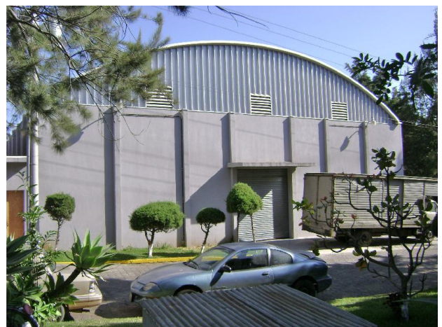
BODEGA PRODUCTO TERMINADO PHARMAPLAST
