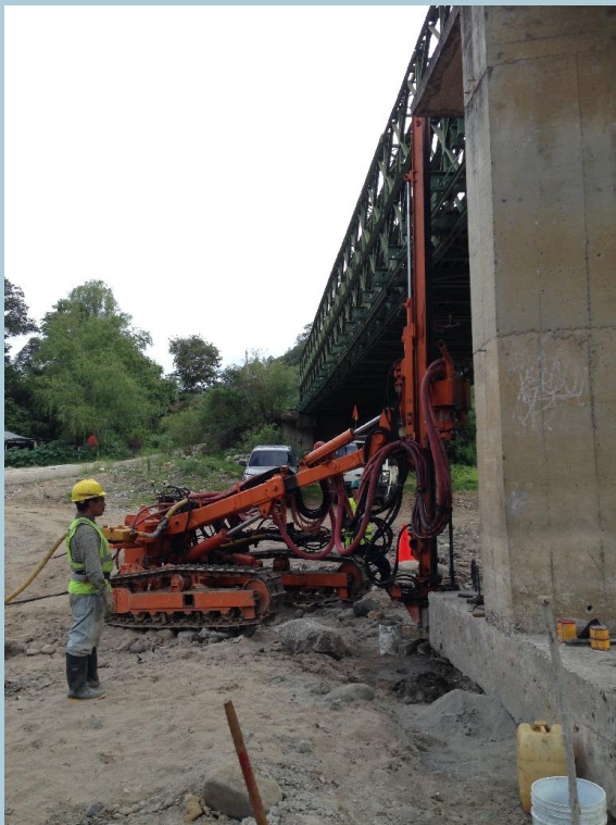
PUENTE SIETE PLATOS MINA MARLIN, SAN MIGUEL IXTAHUCAN, SAN MARCOS, GUATEMALA
